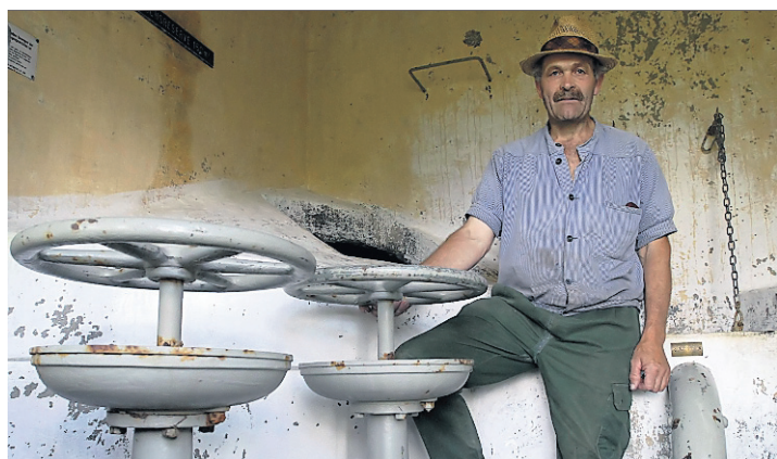
WASSER Es bleibt in Bleienbach ein Thema, wie schon 2007, als Fritz Sollberger das alte, renovationsbedürftige Wasserreservoir zeigte. UL
